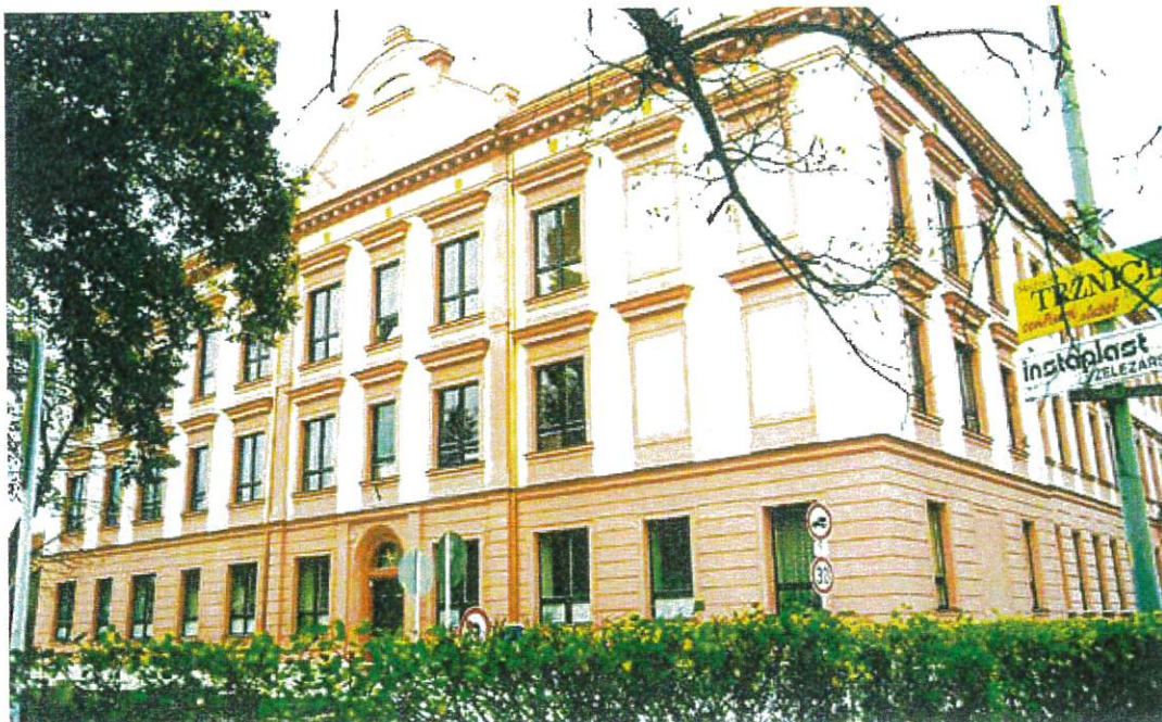
V listopadu 2000 byla dokončena oprava fasády budovy v Jungmannově ulici
